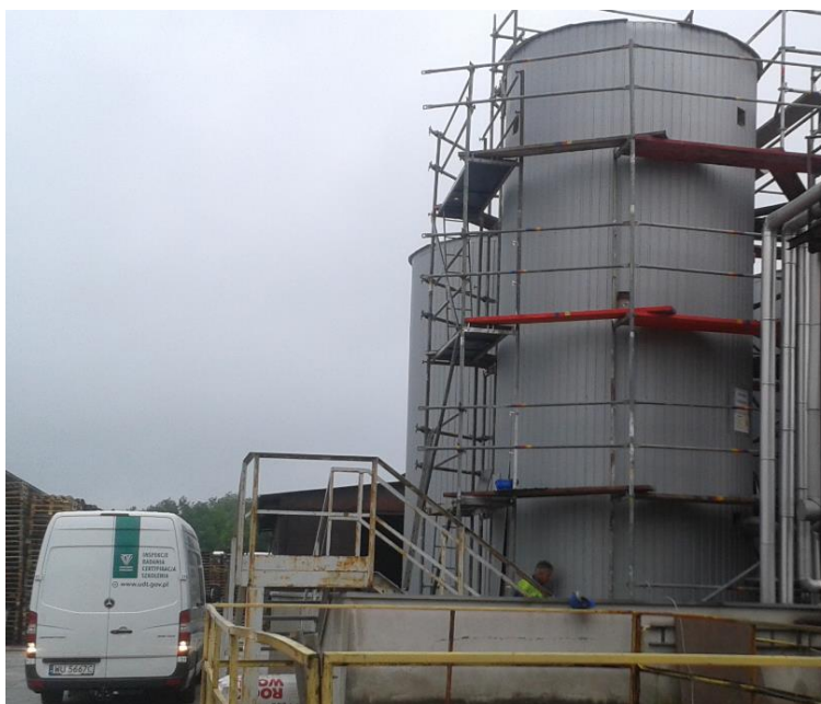
Rys.6. Widok badanego metodą AE zbiornika magazynowego.
